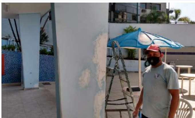
Reparos e pintura
