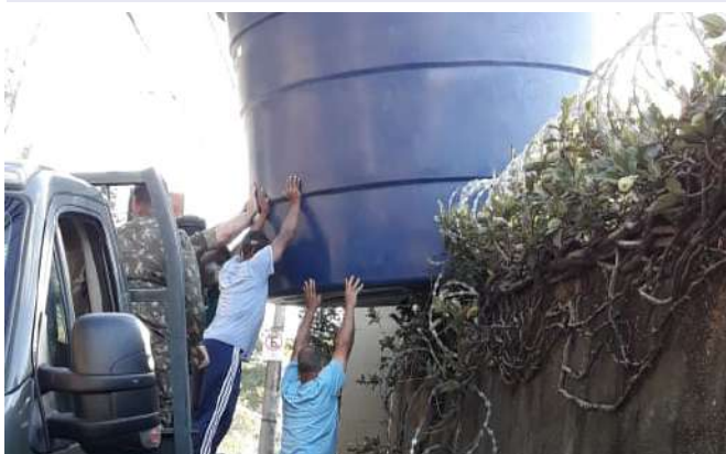
Instalação da nova caixa d'água
