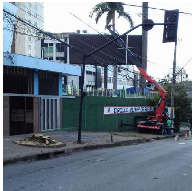
Novo painel digital instalado no clube
